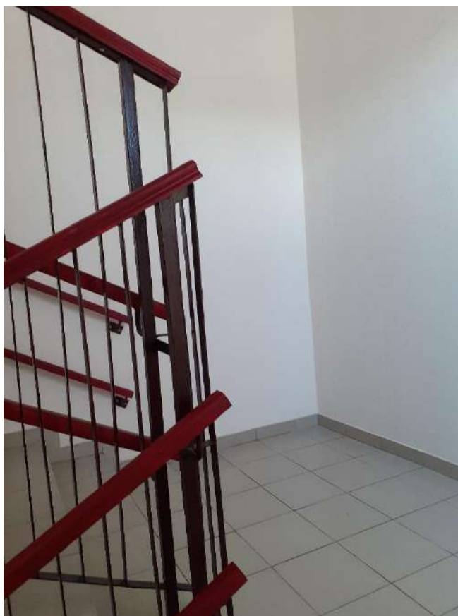
Фото 18-19 - Лестница (внутри здания)
